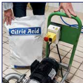
Fase 11 Detener la bomba y añadir el ácido cítrico al agua de lavado.
