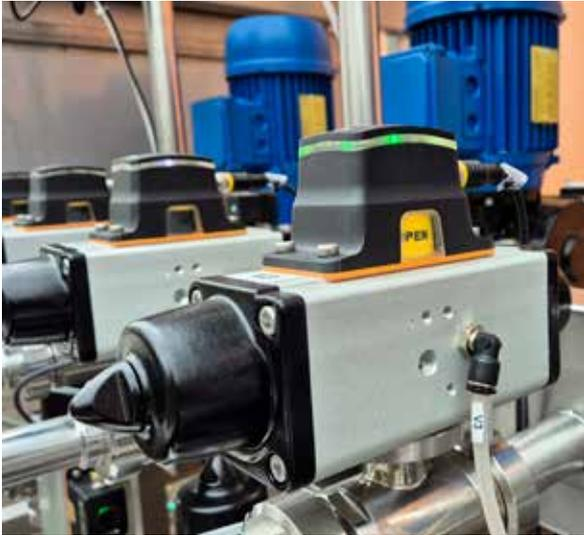
**N. 14 VALVOLE PNEUMATICHE** complete di attuatore e sensore di prossimità
