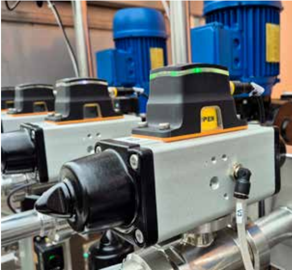
N. 14 VÁLVULAS NEUMÁTICAS completas con actuador y sensor de proximidad
